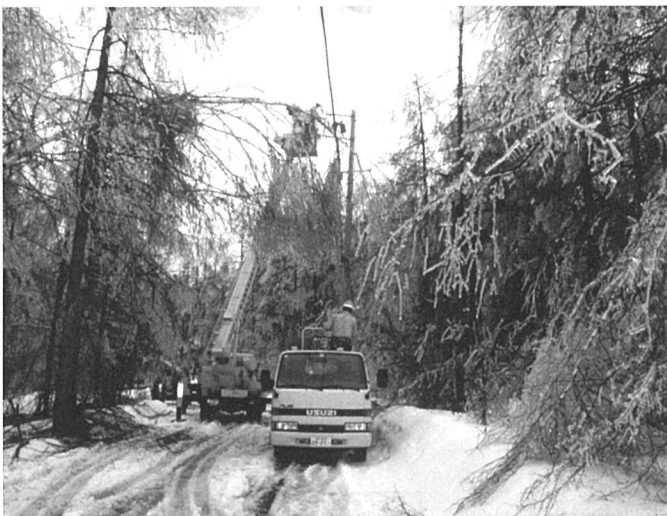
復旧作業が進められる現場
