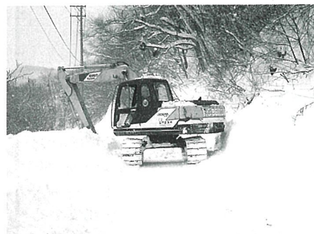
大型バックフォーによる除雪
